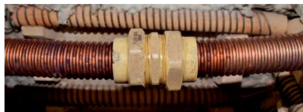
Rys. 6. Próbkę DN 28 po badaniu szczelności w przypadku ognia
