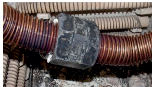
Rys. 7. Próbkę DN 50 po badaniu szczelności w przypadku ognia
