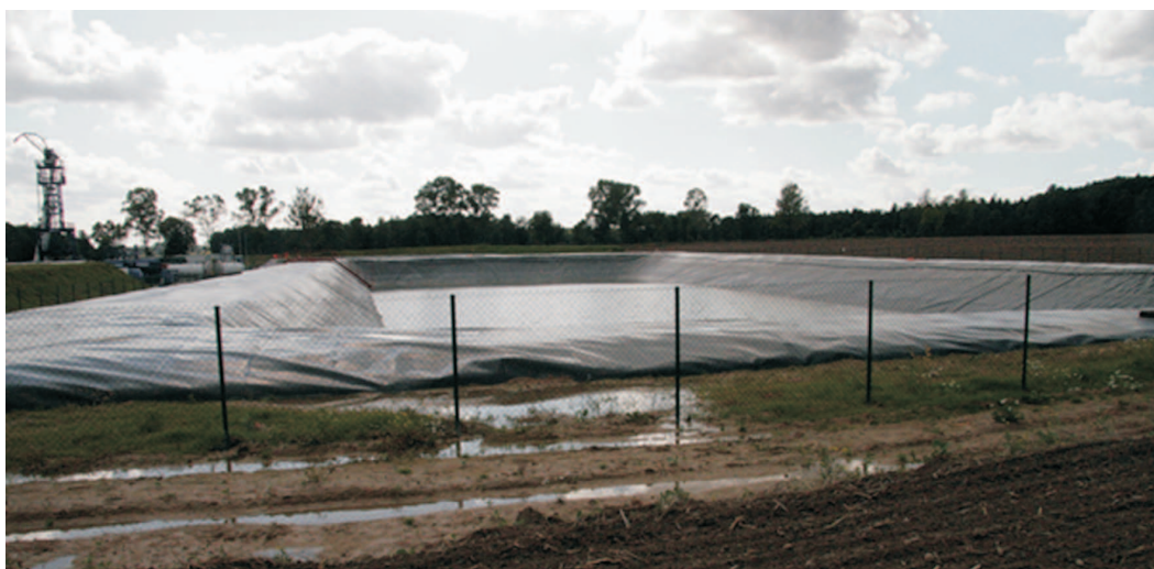
Fot. 1. Otwarty zbiornik na płyn odzyskany po zabiegu szczelinowania hydraulicznego
