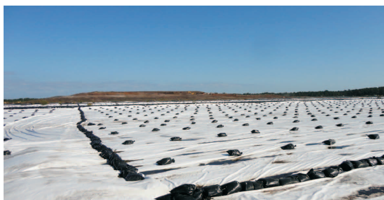
Fot. 2. Widok na kwatery 11 i 12 składowiska Orange County Landfill
