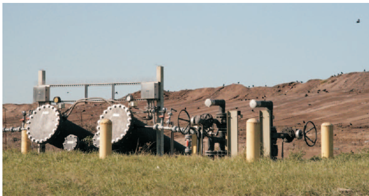
Fot. 1. Widok na kwatery 9 i 10 składowiska Orange County Landfill
