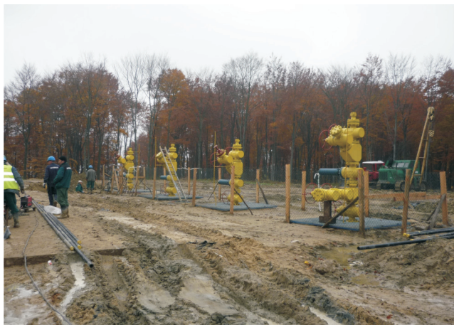
Rys. 3. Odwierty nr SH5, SH6, SH7 i SH8 na Ośrodku Grupowym nr 2
