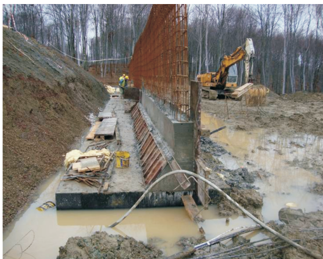
Rys. 5. Budowa muru oporowego na Ośrodku Centralnym
