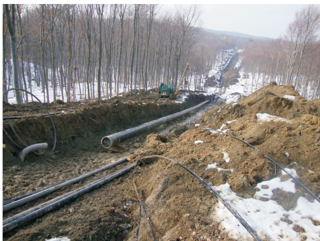
Rys. 1. Budowa gazociągów łączących Ośrodek Grupowy nr 2 z Ośrodkiem Centralnym
