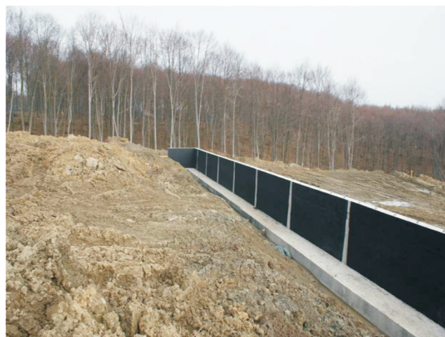
Rys. 6. Wykonany mur oporowy w osi "B" na Ośrodku Centralnym
