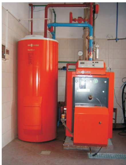
Rys. 1. Kocioł olejowy Viessmann Paromat Triplex o mocy 80 kW
